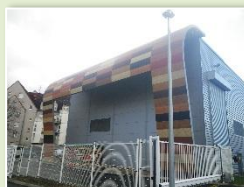
COLMAR – SCCU foyer à grilles – 8 MW
