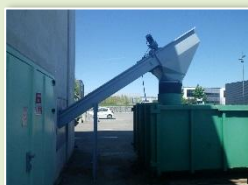
RIXHEIM VALORIM foyer à grilles – 2,8 MW
