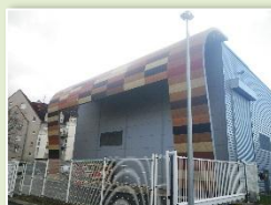
COLMAR – SCCU foyer à grilles – 8 MW
